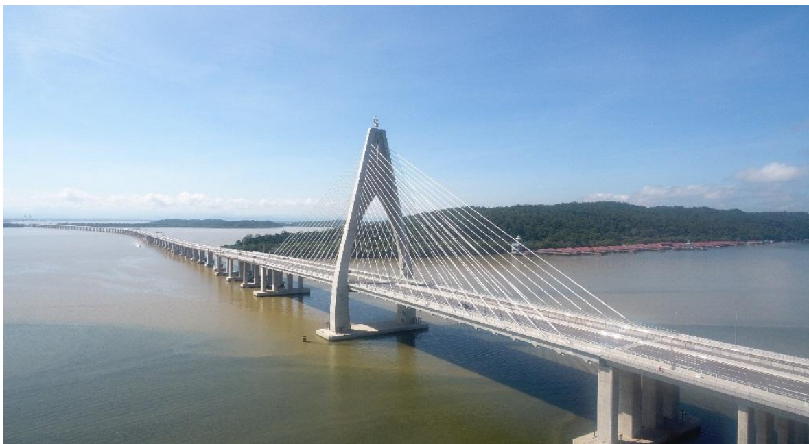
中资企业参与承建的文莱淡布隆跨海大桥
